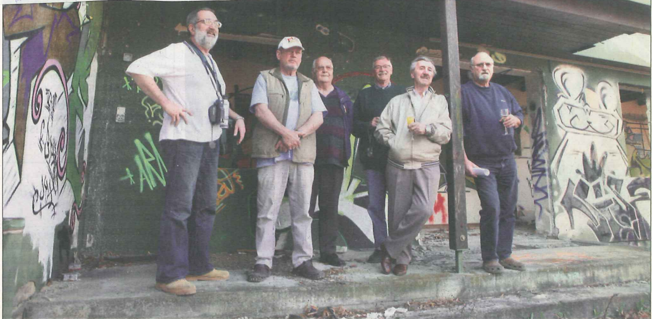
Das Äußere der Sergeants-Mess an der heutigen Georg-Schaeffler-Straße hat sich in den 17 Jahren des Zerfalls bis
